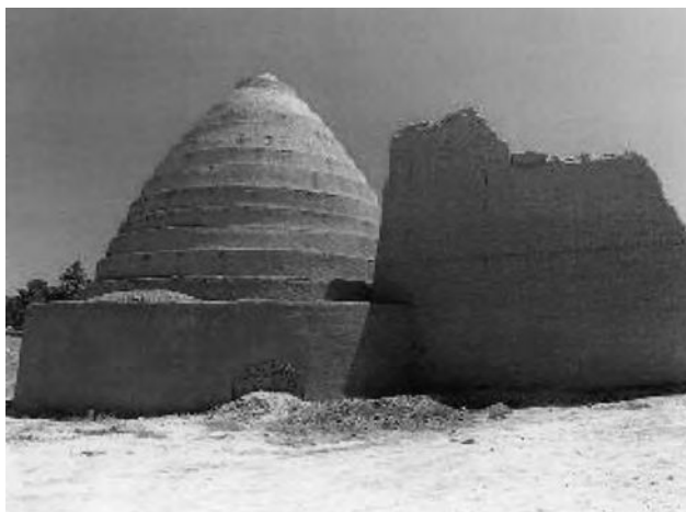
Figura 5. Construcción vernácula en Irán.
