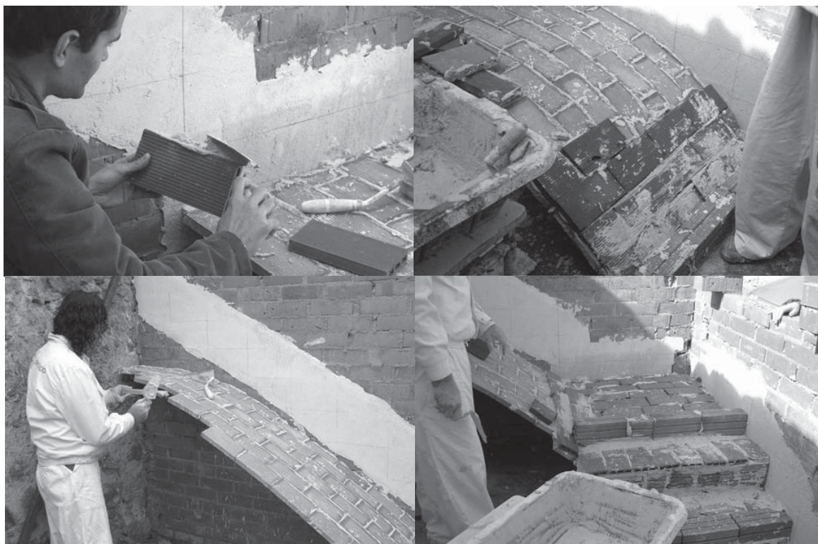
Láms. 13 a 16. Varios alumnos intentan colocar una rasilla húmeda. Arranque de la segunda rosca. Terminación de la primera rosca. Peldañeado.
