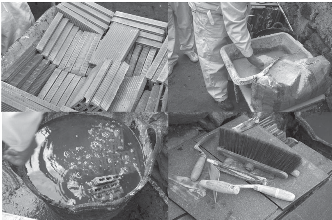
Láms. 3 a 6. Herramienta y materiales utilizados en la construcción de la escalera tabicada. Paletas y paletines, yeso y rasilla. Para la primera rosca se emplea rasilla seca. La segunda y siguientes se realizan con rasilla húmeda.
