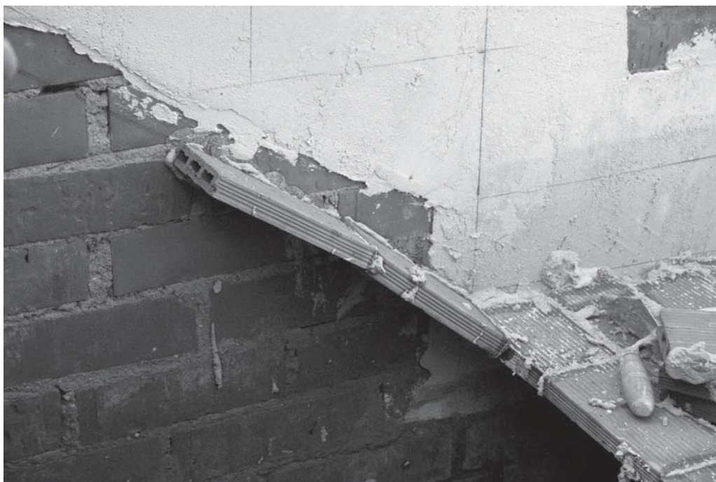
Lámina 12. Arranque del segundo tramo sobre el primero. La primera pieza del tablero de arriba monta sobre el vivo superior del de abajo.
