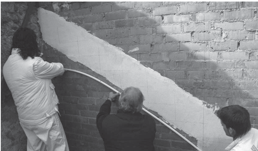
Lámina 1. Marcado de los peldaños sobre el tendido de yeso.
