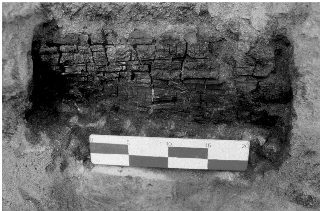
Figura 7. Viga de madera de pino carbonizada embutida en un muro de Cauca (foto, el autor).
