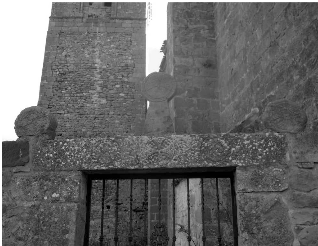
Figura 11. Dintel de la puerta de acceso al actual cementerio. Fotografía: C. de la Casa.
