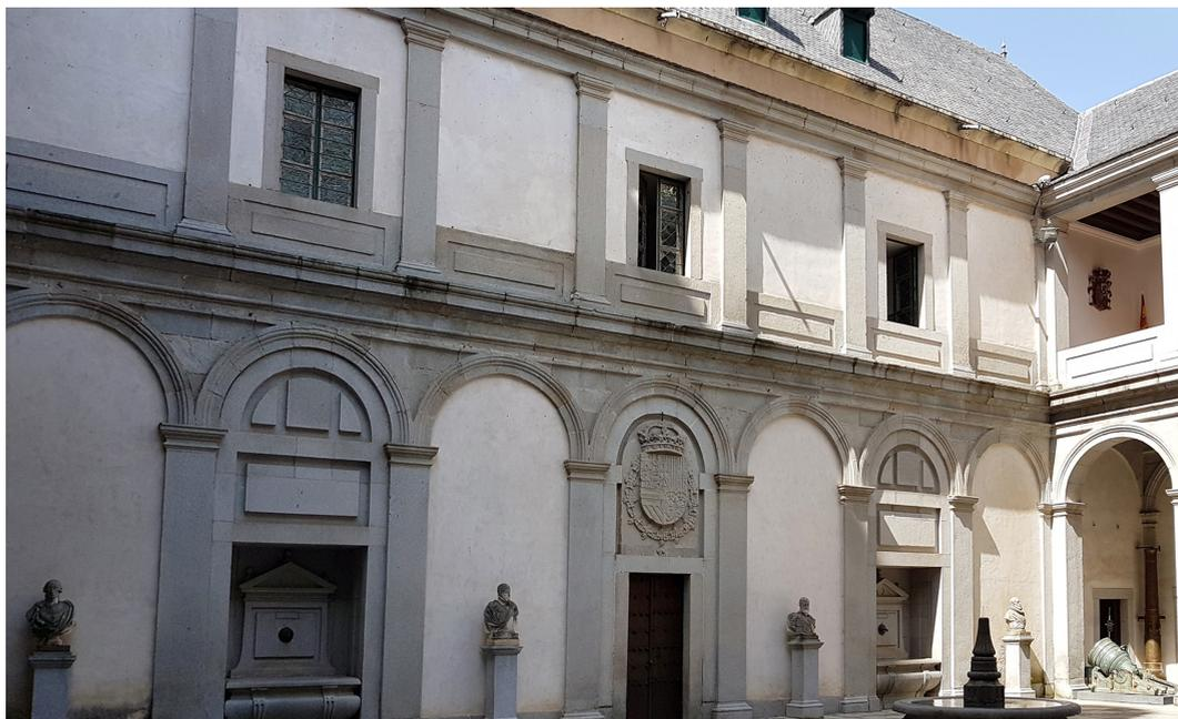
Figura 18. Falsos arcos y pilastras embutidos en la pared del cuarto del Mediodía del patio.
