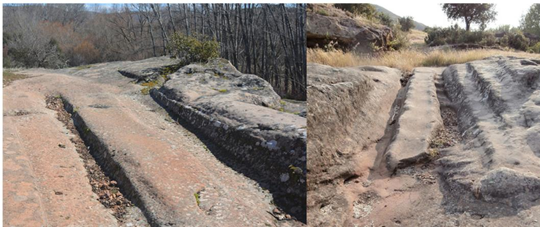
**Figura 14.** Detalle del tallado de la roca: sin canales de desagüe y con prominentes canales para impedir la acumulación de agua, en el mismo tramo de vía que se dirige a Carratermes, dispuestas de forma consecutiva.
