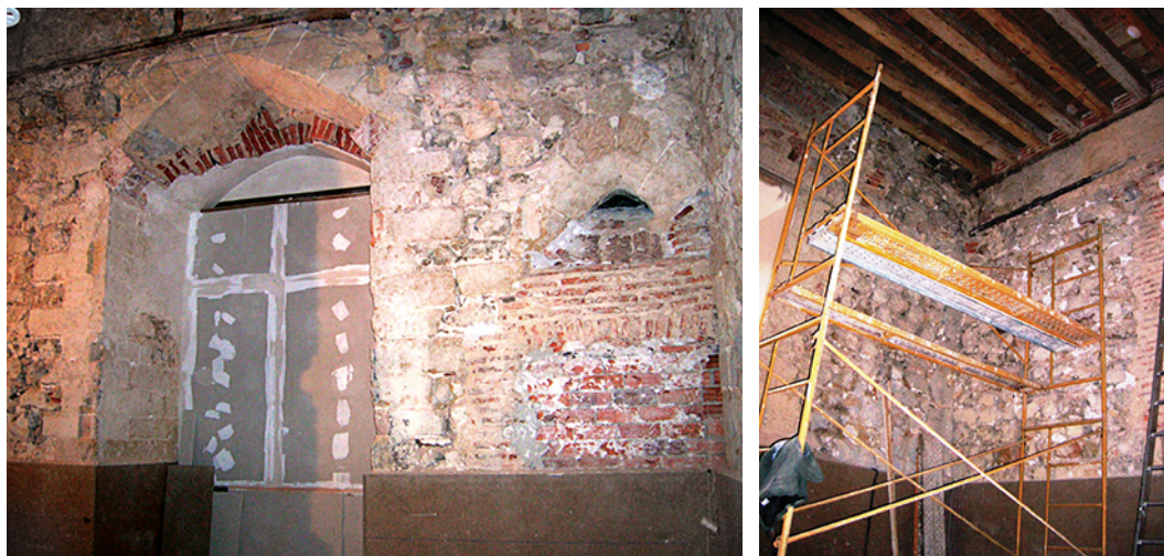
Figura 10. Encuentro del engrosamiento del muro N de la sala de la Chimenea con el muro cortina. Foto. APAS.
