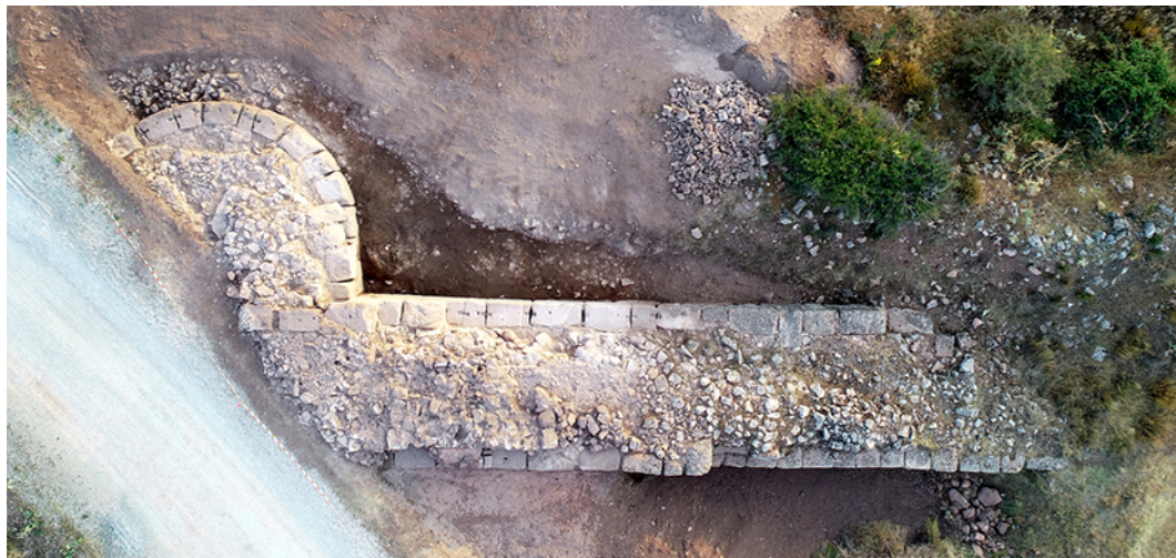
Figura 2. Vista aérea del nuevo cubo (n.º 5) descubierto durante la campaña de 2021 (Fotografía: Pablo Arribas).
