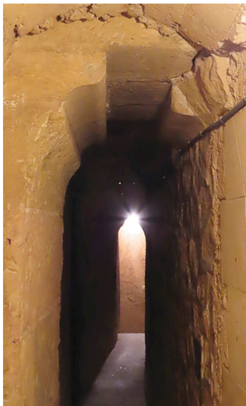
Figura 19. Líneas de unión de fábricas en la torre S.
