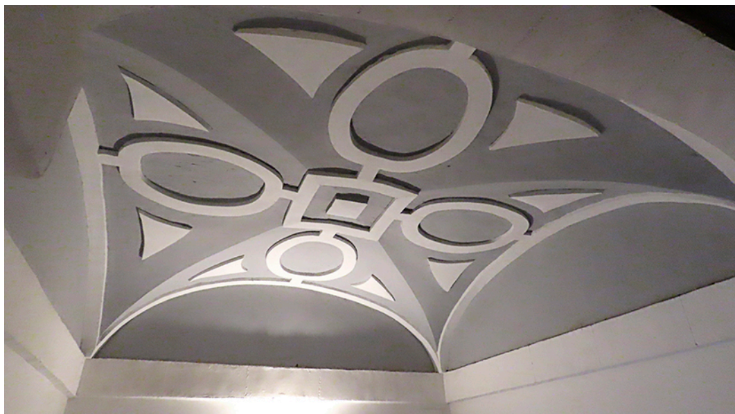
Figura 28. Bóveda de arista sobre la escalera entre las torres.
