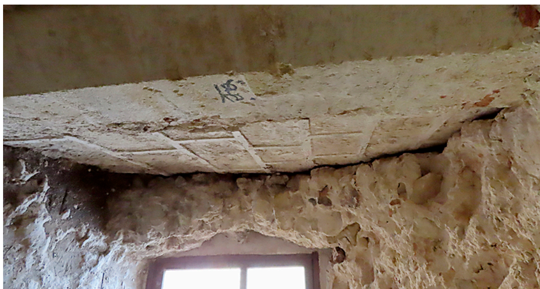
Figura 29. Pilastra y línea de unión de fábricas en la segunda planta de la torre de Juan II.
