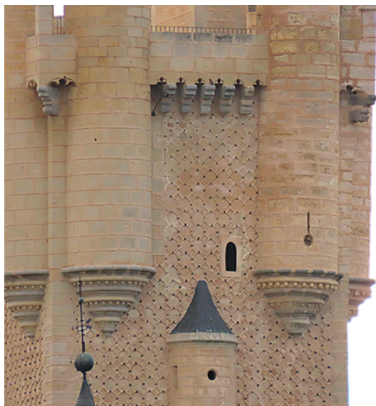
Figura 35. Tronera en la base de la escaraguaita de la esquina NO de la torre de Juan II.
