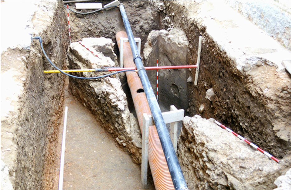
Figura 3. Detalle de estructura en calle Soledad.
