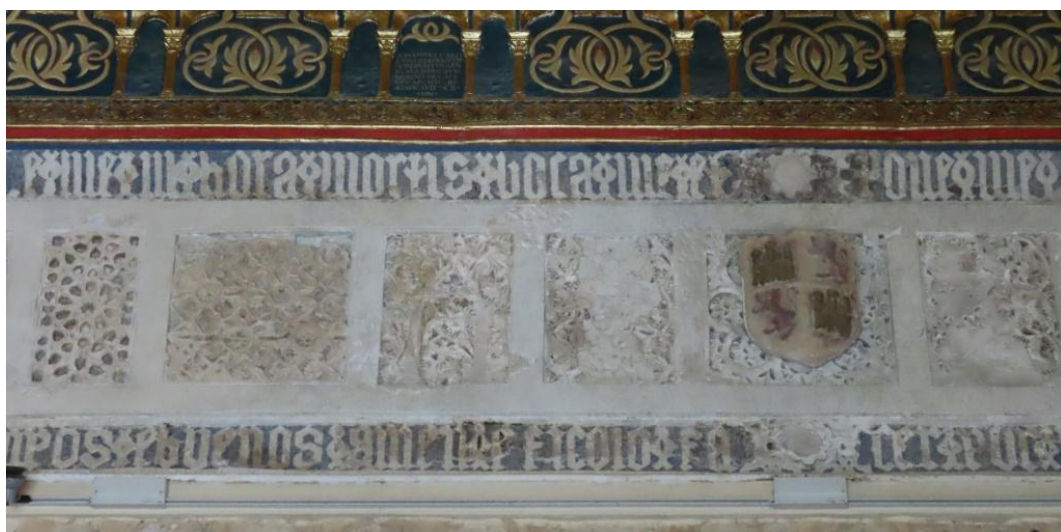
Figura 10. Estado del friso, después de la intervención de 2008. Foto: autor.
