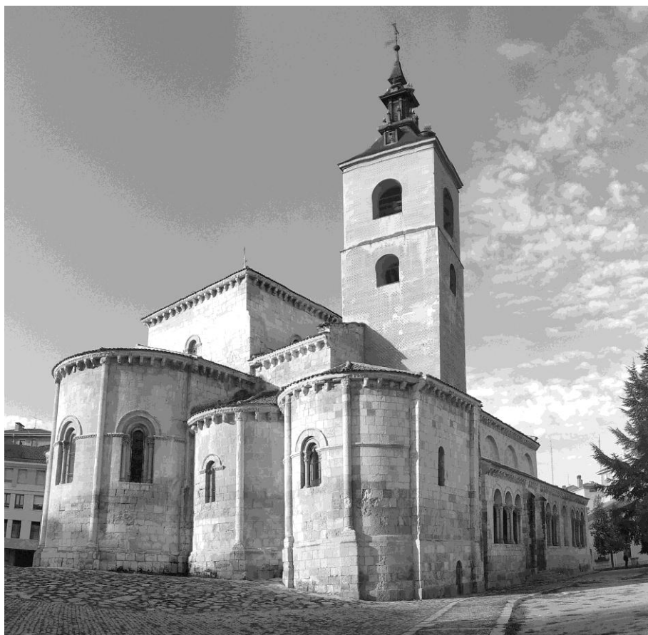
Figura 2. Iglesia de San Millán: fachada norte y cuarto ábside.
